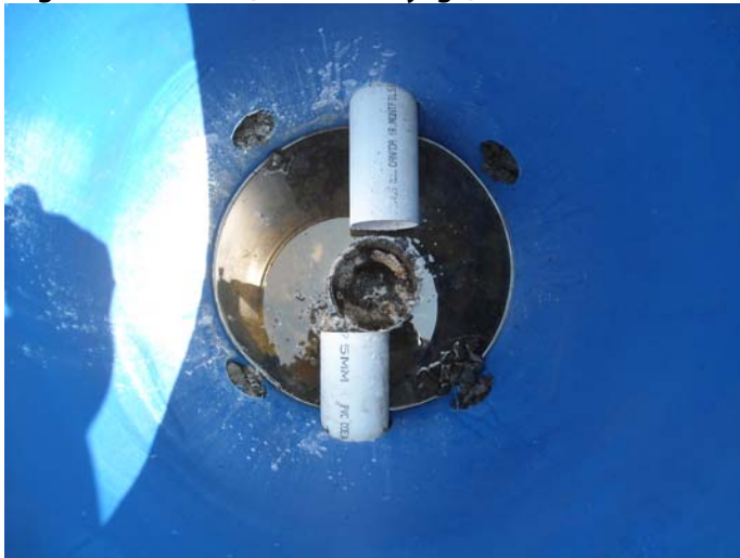
Regard de collecte (avant nettoyage)
