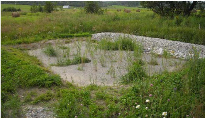
Bassin de roseaux (avant désherbage)
